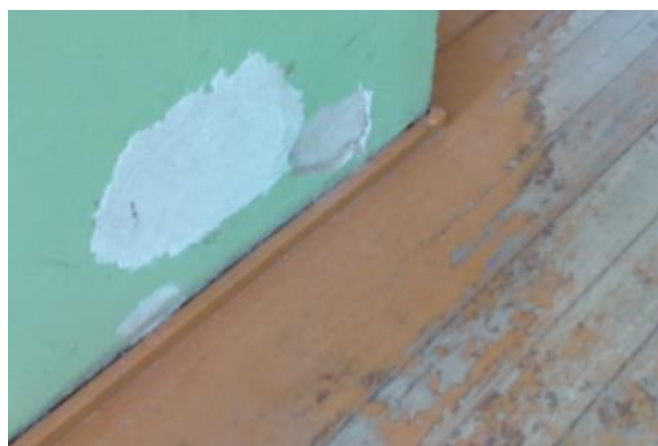
7 pav. Neremontuotų patalpų sienos stipriai nusidėvėję
